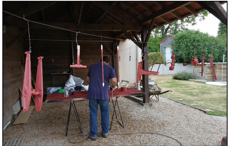
Ci-dessus le sablage de la partie cycle avant d'appliquer le primaire rouge, puis microbillage de la visserie.
